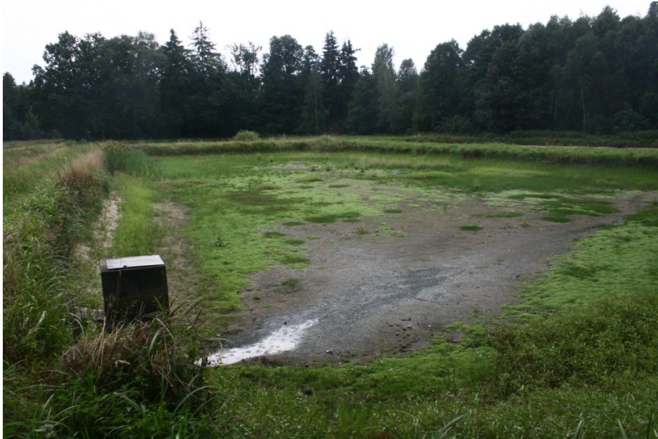
Abb. 3. Abgelassener („gesömmert“) Ablaichteich im Charlottenhofer Weihergebiet. Links unten ist das Ablassbauwerk, der Mönch („ der in die höhe gerichtete spund oder zapfen im ablasz eines teiches; aber auch manchmal der ganze ablasz selbst “; GRIMM & GRIMM 1854–1960) zu sehen. Nach dem Ablassen hat sich eine typische Teichbodengesellschaft etabliert, hier mit Eleocharis acicularis , Eleocharis ovata , Elatine triandra , E. hexandra , Limosella aquatica u. v. a. (© Foto P. Poschlod).
